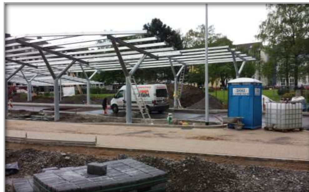
ZOB während der Bauphase
